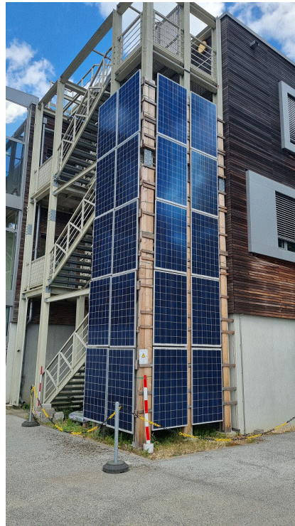
Figure 2 : Modules photovoltaïques intégré sur un garde-corps (à gauche), Modules photovoltaïques intégré sur un escalier extérieur (à droite).
