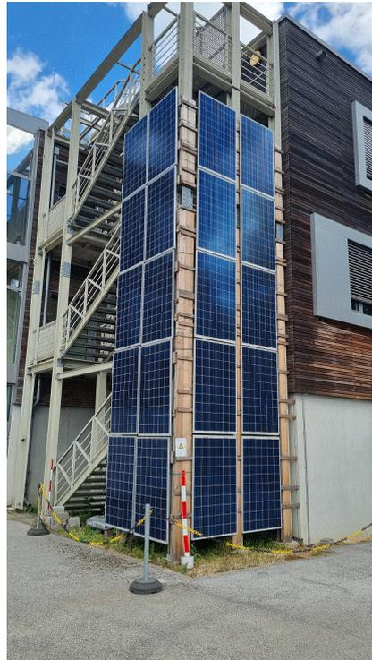
Abbildung 2: PV-Module in ein innenliegendes Geländer integriert (links), PV-Module an einer Außen-Treppe (rechts)
